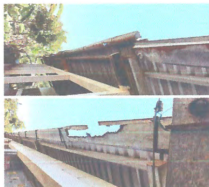
Foto 4: CANALES Y BAJAS DE AGUA PLUVIAL
