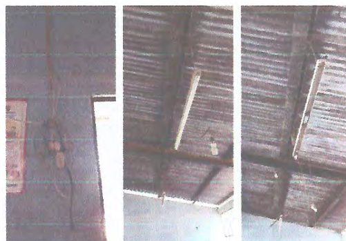
Foto 2: REPARACIÓN DEL SISTEMA ELECTRICO
