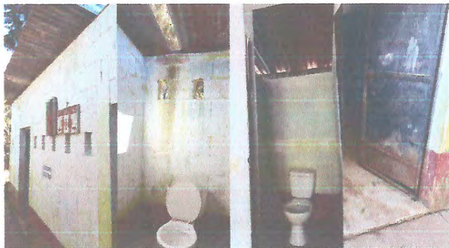
Foto 1: REMOZAMIENTO DE SERVICIOS SANITARIOS
